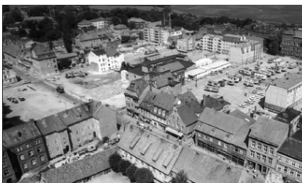
Abb. 10 Greifswald, Blick vom Dom St. Nikolai auf das Quartier nördlich der Langen Straße zwischen Rotgerber- und Kapaunenstraße (Bildmitte). Blick nach Nordwesten. Neben dem hellen Haus Kapaunenstraße 22 blieb lediglich der universitäre Gebäudekomplex Rotgerberstraße 8 vom Flächenabriss verschont (Juli 1989). Foto: Archiv Universität Greifswald
