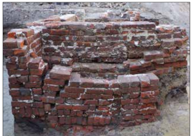
Abb. 19 Greifswald, Lange Straße 23, 25, 27. Die ursprüngliche Südmauer des Kellers im Hofbereich war über einem stratigrafisch älteren Tiefbauwerk weggesackt und wurde, nach Norden versetzt, neu aufgeführt. Blick nach Norden. Foto: J. Zorn (2019)
