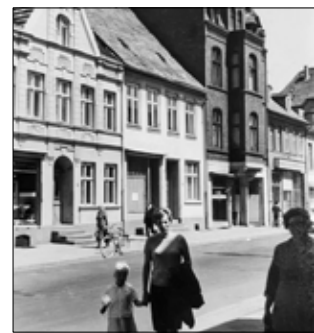
Abb. 8 Greifswald, Lange Straße 71. Der dreigeschossige Vorgängerbau von vermutlich 1682 (siehe Abb. 5) wurde abgerissen und 1899 durch einen roten Backsteinbau ersetzt. Blick nach Nordosten (vor 1981). Foto: Stadtarchiv Greifswald: aic 1836
