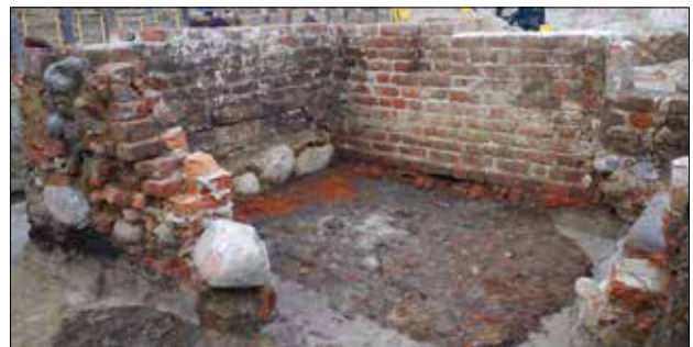
Abb. 18 Greifswald, Lange Straße 23, 25, 27. Südmauer und durch Nischen gegliederte Westmauer des Kellers im Hofbereich. Die Ostmauer war durch eine jüngere Eingrabung massiv gestört. Blick nach Südwesten. Foto: J. Zorn (2019)
