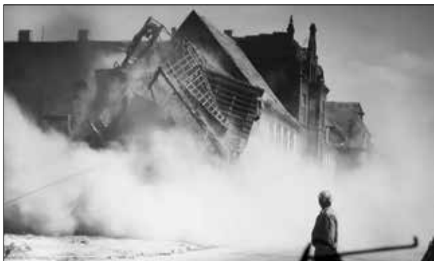
Abb. 9 Greifswald, Abbruch der Gebäude an der Nordseite der Langen Straße zwischen Rotgerber- und Kapaunenstraße. Blick nach Nordosten (Mai/Juni 1989). Foto: Archiv G. Matheisen (Archiv bei Brand im Jahr 2022 vernichtet)
