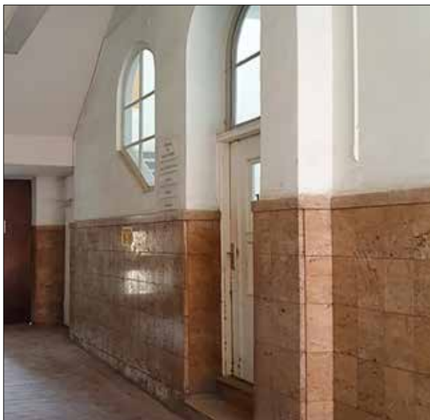
Abb. 23 Greifswald, Rotgerberstraße 8 (ehemaliges Gasthaus „Zur grünen Linde“), Erdgeschoss. Durch den Hof erreichte man durch die vordere Eingangstür die Räume des Gasthauses (kleiner Flur), im hinteren Teil befand sich der Treppenabgang in den Keller. Foto: T. Klinke (2023)
