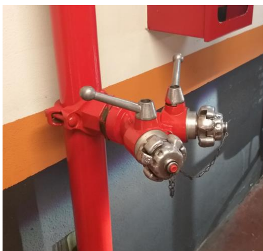
Abbildung 18 Anschlussmöglichkeiten an eine Steigleitung mit mehreren Abgängen
