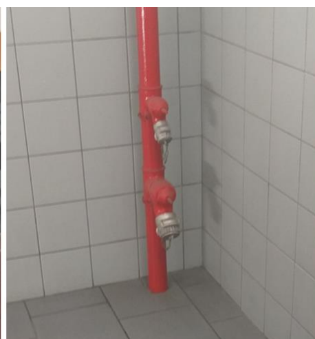
Abbildung 18 Anschlussmöglichkeiten an eine Steigleitung mit mehreren Abgängen
